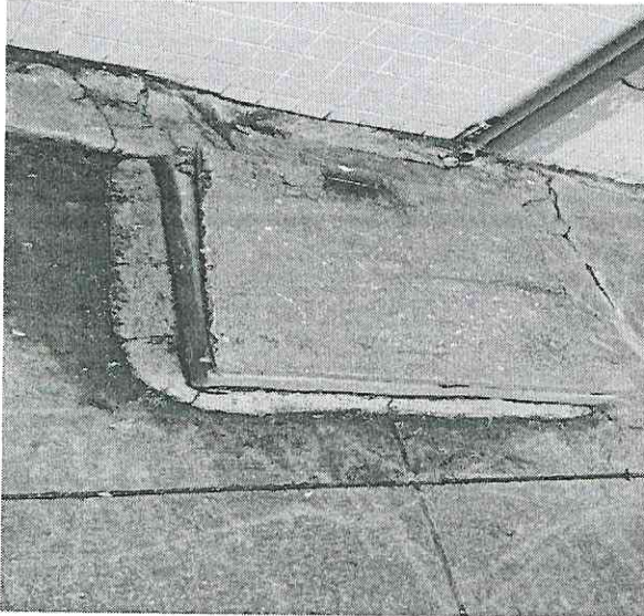
1. Vista lateral (direita) área de instalação de grade – divisa.
