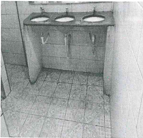
1. Vista da pia do banheiro infantil - feminino.
