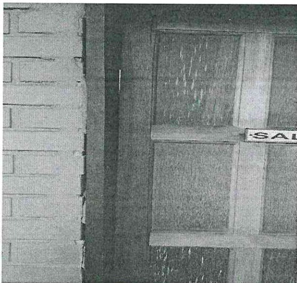
1. Vista da porta empenada.
